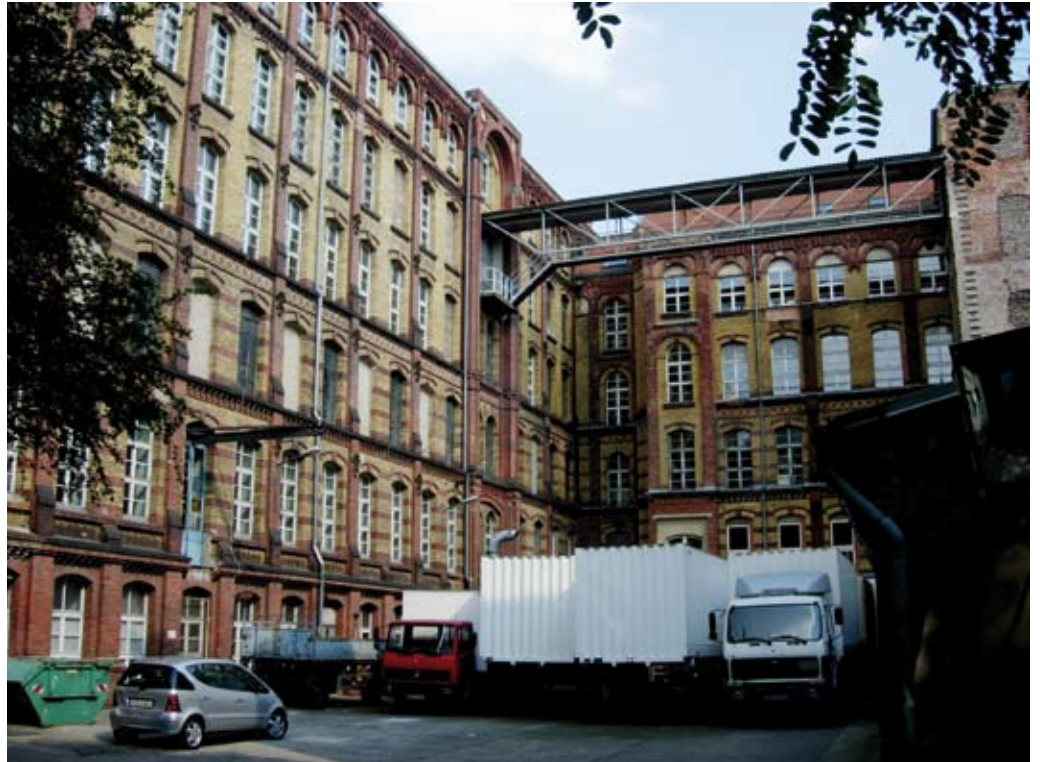
Hauptgebäude, südlicher Seitenflügel und Vorderhof Main building, southern side wing and front courtyard
