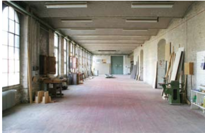
Innenansicht Hauptgebäude Erdgeschoss Interior, main building, ground floor
