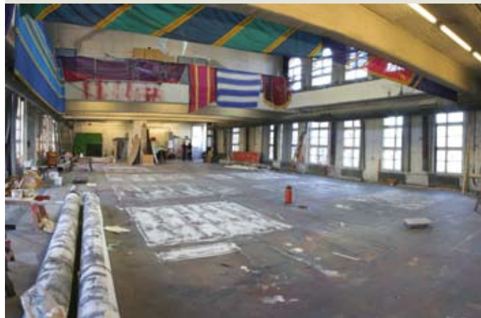
Innenansicht Hauptgebäude 4. Obergeschoss Interior, main building, 4th floor
