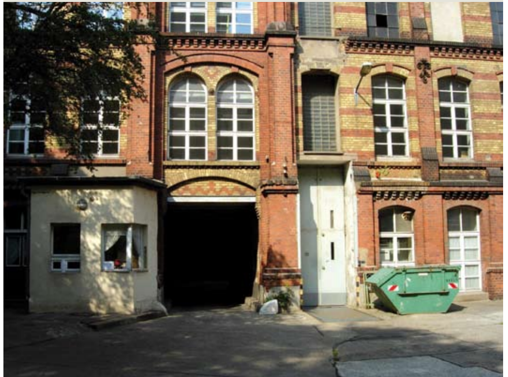
Durchfahrt zum Hinterhof Passageway to back courtyard
