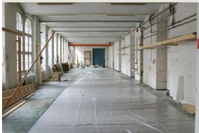
Innenansicht Hauptgebäude 1. Obergeschoss Interior, main building, 1st floor
